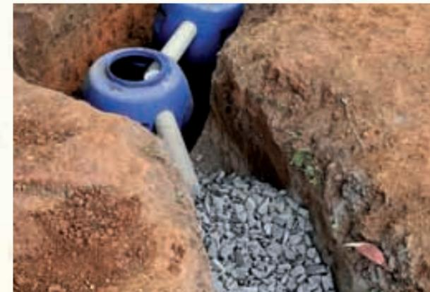
Os próprios moradores se encarregam da compra dos materiais e auxiliam os técnicos da prefeitura, que realizam a instalação da fossa séptica econômica. O custo é de apenas um quarto do valor necessário para construir uma fossa de alvenaria.
